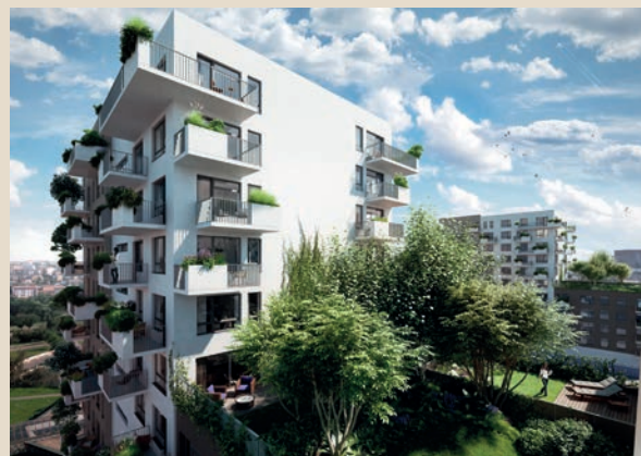
V Praze staví aktuálně UDI Group projekt Bytové domy Lužiny přímo naproti stejnojmenné stanici metra.
